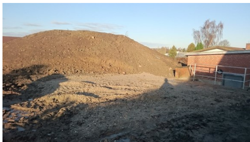
Den nye vandtank er på plads og tildækket
