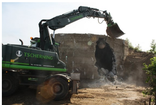
Den gamle betontank med revner fjernes
