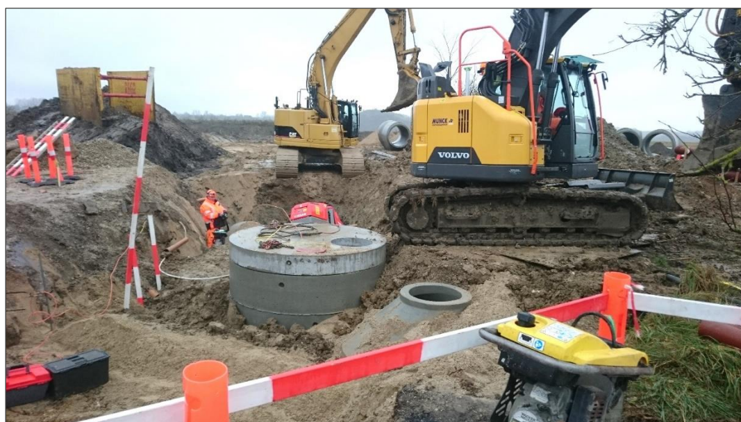
Klimahusene er ved at byggemodne til 21 nye huse på Flintebjergvej i Reerslev
