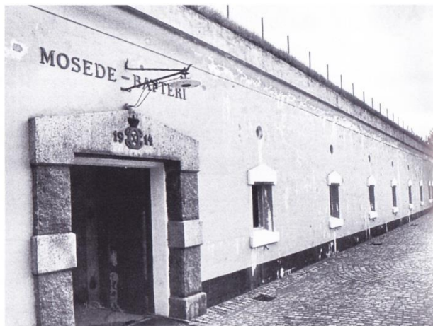
Mosedebatteri, opført 1913-16, nedlagt 1.11.1970
